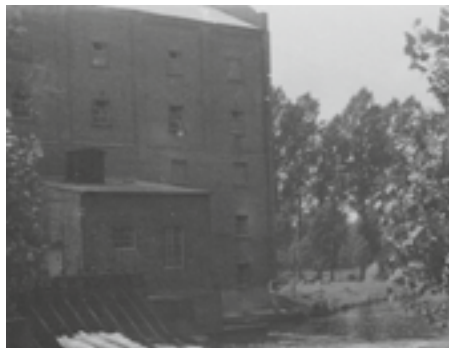
Mühle mit Turbinenhaus
