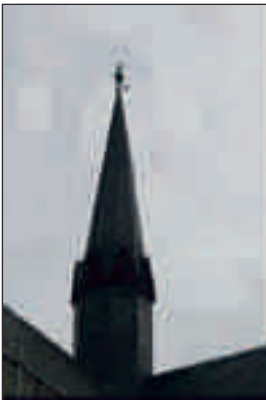
Turmerneuerung auf der Vierung
